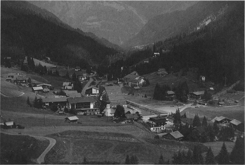
Foto 8: Gargellen 1989, Blick nach Norden. Im Vordergrund Lawinenleitdämme der Alptobellawine zum Schutz des Ortszentrums. Am re. Bildrand (Mitte) Lawinenleitdamm der Kälberhaldenlawine zum Schutz des Hotels „Heimspitze“.
